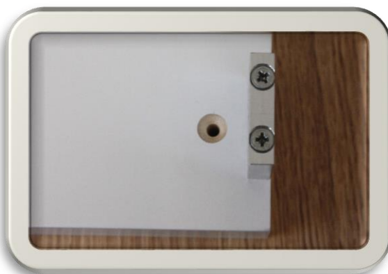
Nederkant borrar likadant 15 mm från ovankant brickan
