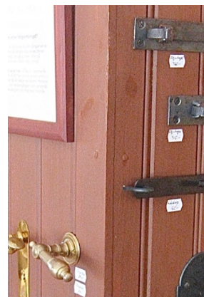
Efter en och två strykningar med färg ovan kvisten så ser man fortfarande en liten shellack-ö. Den försvinner efter en tredje strykning med linoljefärg.
