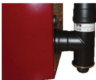
Fig. 73 - Fume conduit cleaning
