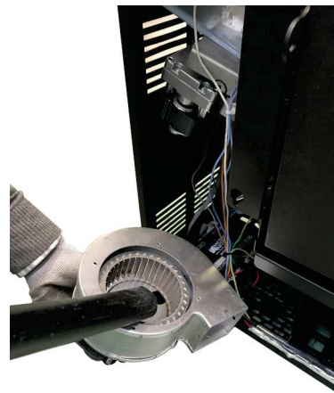
Fig. 95 - Room fan cleaning
