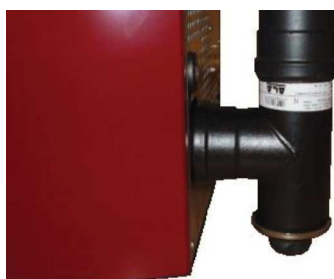
Fig. 87 - Fume conduit cleaning
