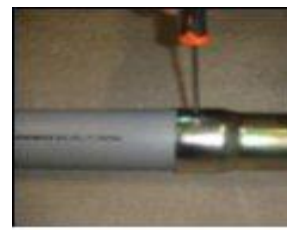
14. Fäst plaströret med medföljande skruv.
