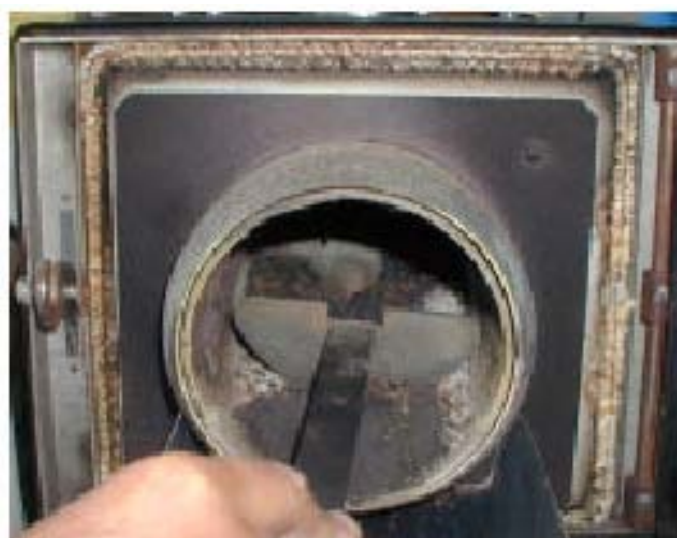
Skrapa ur aska och slagg med den medföljande askrakan.
