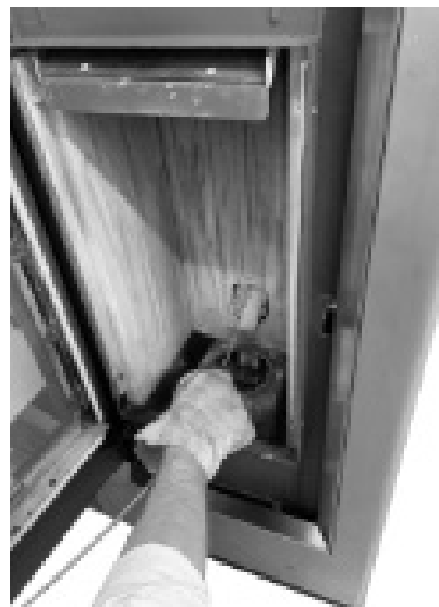
Fig. 40 - Rengöring med piprensare
