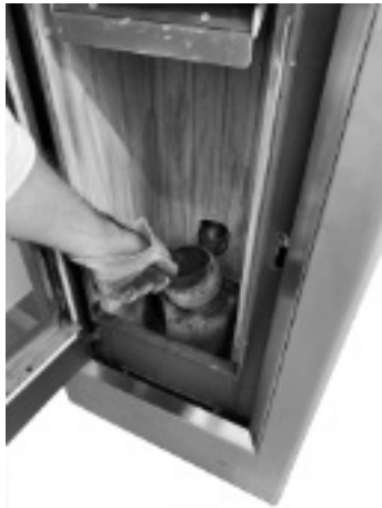
Fig. 33 - Borttagning av brännkopp
