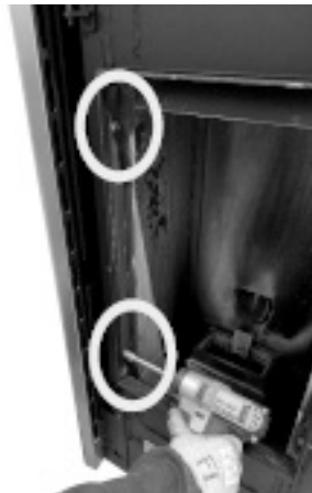
Fig. 46 - Ta bort sexkantsskruvarna
