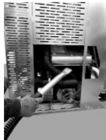
Fig. 58 - Rengöring av rumsfläkt 2
