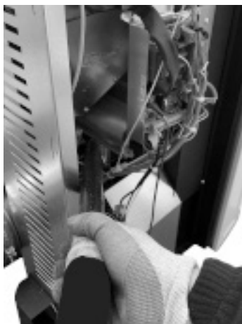
Fig. 57 - Rengöring av rumsfläkt 1
