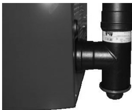
Fig. 45 - Rengöring av rökkanal
