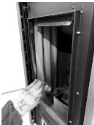
Fig. 51 - Rengör med en rörrengöringsborste
