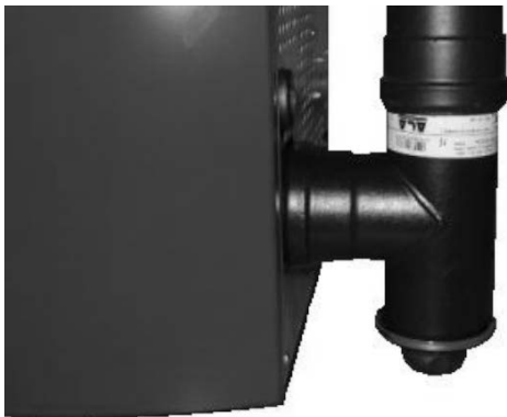
Fig. 64 - Rengöring av rökkanal
