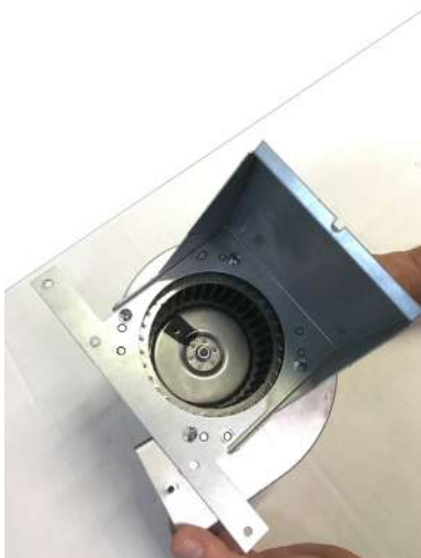
Fig. 41 - Fan + casing
