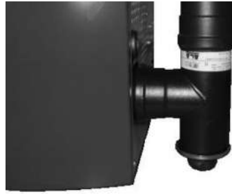
Fig. 53 - Fume conduit cleaning
