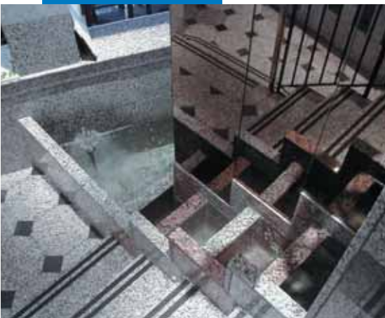
Granitt gulv og vegg lagt med Keraquick + Latex Plus - Caesaris Palace in Merseyside - Liverpool (GB)
