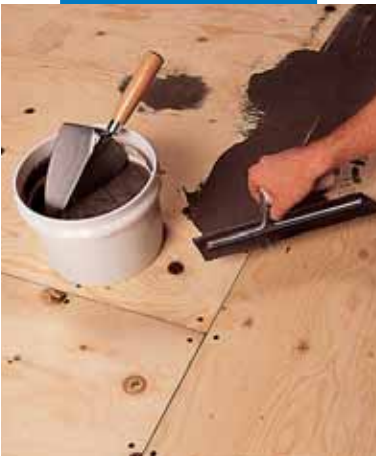
Sparkling på kryssfiner med Nivorapid + Latex Plus
