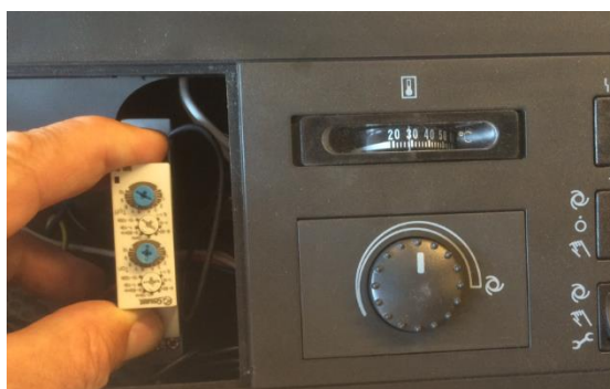
Figur 6 Inställning av askutmatningstider
