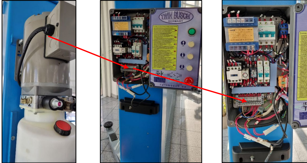
Bild: Ansluta strömförsörjningen till styrenheten
