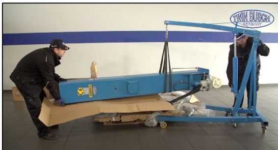
Illustration: Flyttning av pelaren med en motordriven kran
