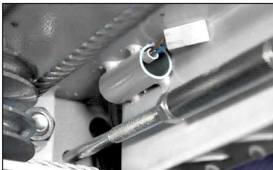
Bild: Kabel under körbanan
