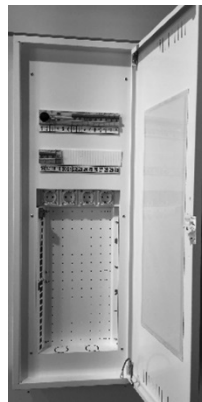
Infälld multimedia central Se 9.517
