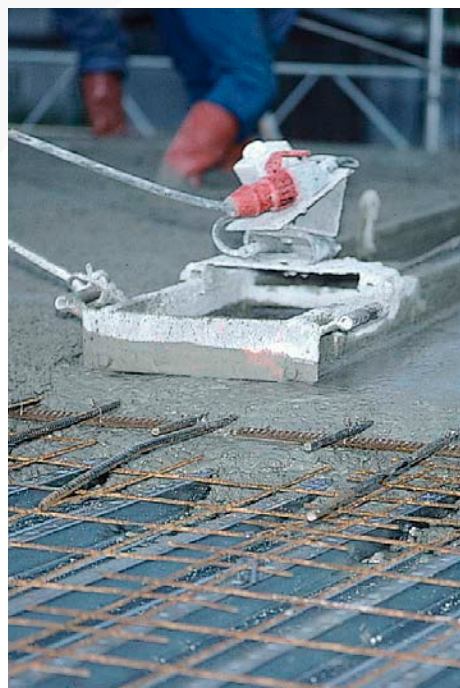
Betongpågjutning görs till färdig yta i ett moment.
