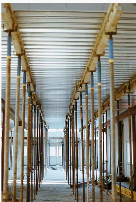
Ett glest lager bockryggar stöttar plåten under gjutfasen.
