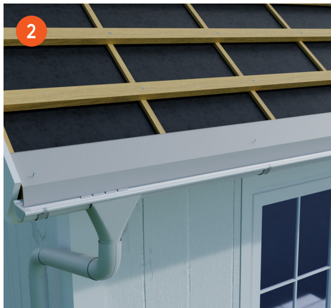
Montera fotplåten på nedersta bärläkten med träskruv. Var noga med att plåten ligger i rät linje längs bärläkten.
