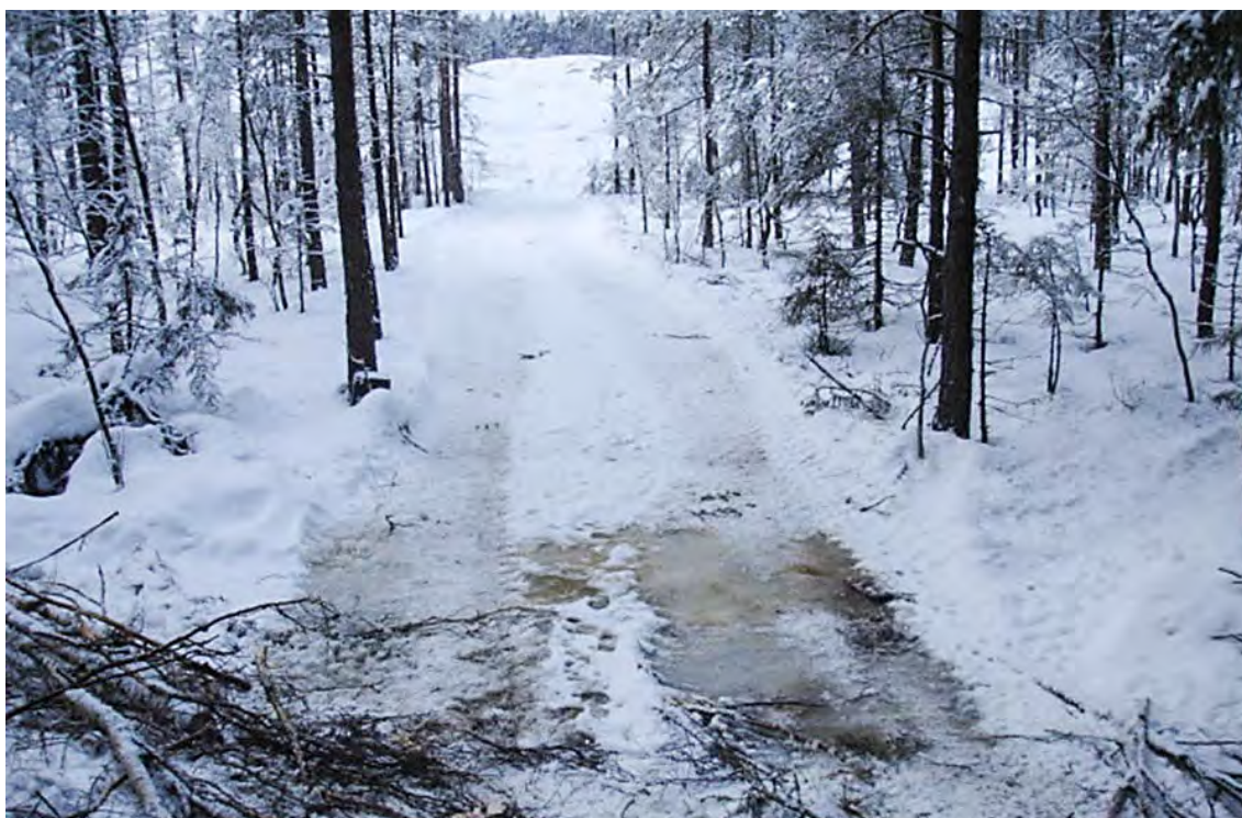
Trampad vinterväg. När minusgraderna kommer kan vägar börja "trampas" med fyrhjuling, bandmaskin, skoter eller traktor. Kör med en så lätt maskin som möjligt från början. Då plattar man till marken och den fryser ihop vilket gör att tjälen går djupare ner i marken.
