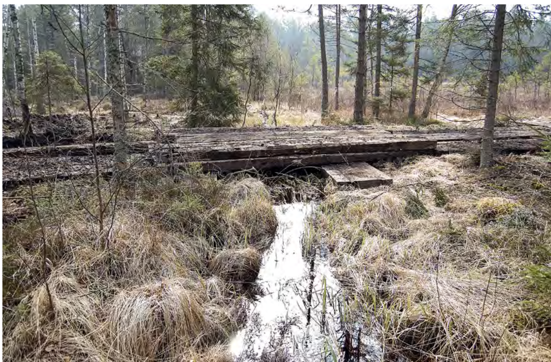
Stockmattor, här använda för överfart över bäck med omgivande våtmarksområde.
