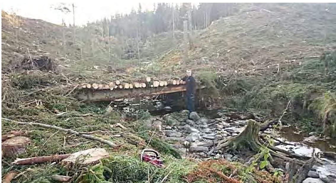
Den (hittills) längsta kända virkesbron har ett spann på cirka 10 meter. Skördarföraren har byggt den av virke och ris från platsen. Foto: Anders Dahlström
