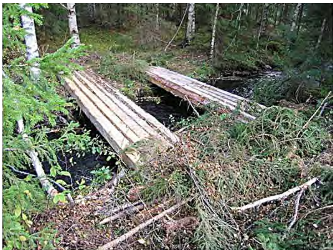
Stockmattor, här använda för överfart över dike. De kan även användas för att förstärka marken. Foto: Anja Lomander
