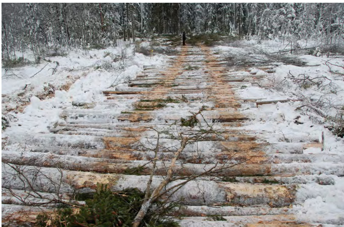
Figur 20. Kavling, vilket innebär att man placerar grövre toppar eller massaved längs marken där man avser att köra, är ett bra sätt att förstärka riktigt känsliga partier. Foto: A. Lomander
