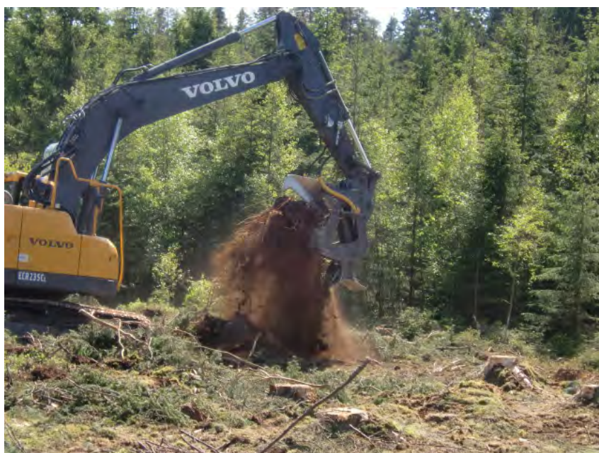
Figur 12. Skörd av stubbar utgör idag en mycket liten andel av uttaget av biobränsle från skogen. Åtgärden medför att rötternas armerande förmåga minskas och mineraljord blottläggs. Foto: A. Lomander
