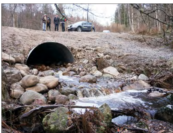
Figur 42. Genom att skapa trappor av stockar eller sten kan man också få vattnet att tappa energi och därmed rinna långsammare. Exemplet visar åtgärder i naturliga bäckar, men åtgärderna lämpar sig i såväl produktionsdiken på skogsmark som längs vägdiaken. Vid åtgärder i rensade rätade vattendrag eller naturliga vattendrag måste alltid kontakt med Länsstyrelsen tas då denna typ av åtgärd kan orsaka vandringshinder för fisk. Foton: K. Lundström och J. Hagström
