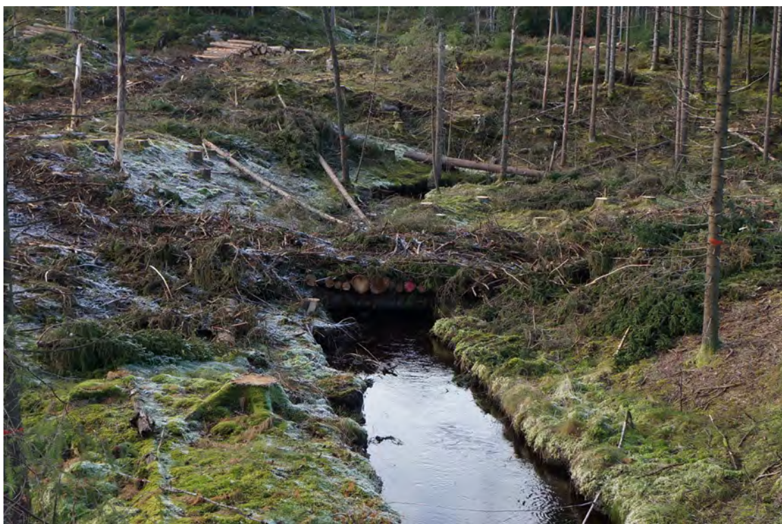
Figur 47. Med hjälp av virke och ris kan en skördare bygga broar över vattendrag på upp emot 10 meters bredd. Foto: J. Hagström
