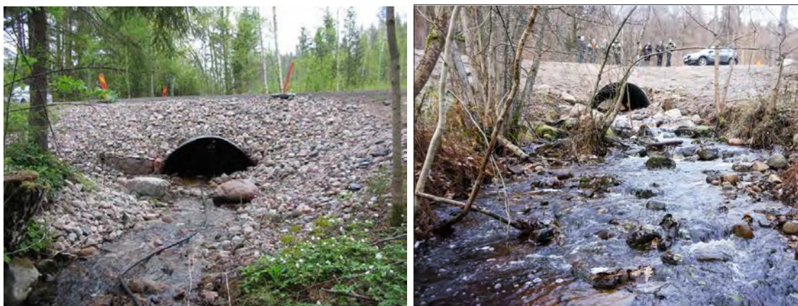
Figur 49. Exempel på halvtrumma/valvbåge som har använts för korsande av naturliga vattendrag. Stenar har lagts i och bibehållits på botten för att inte störa fisk och andra vattenlevande organismer. Inlopp och vägslånter är erosionssäkrade. Foton: S. Gunnarsson, J. Hagström
