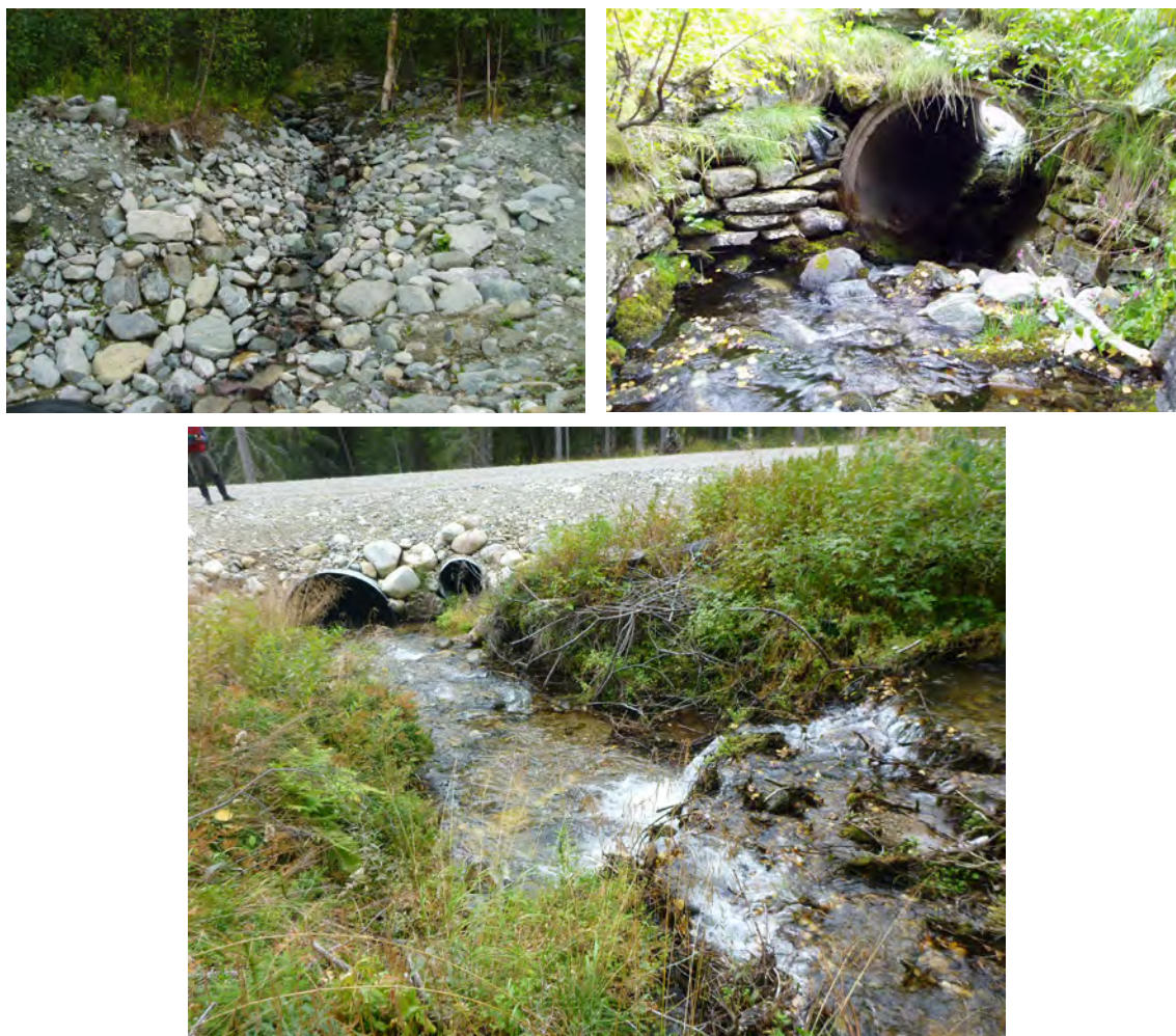
Figur 35. De två övre bilderna visar exempel på erosionsskydd av slänt i anslutning till in- och utlopp av trummor. Den nedre bilden visar erosionsskydd av inlopp som kombinerats med en reservtrumma för höga vattenflöden. Foton: K. Lundström
