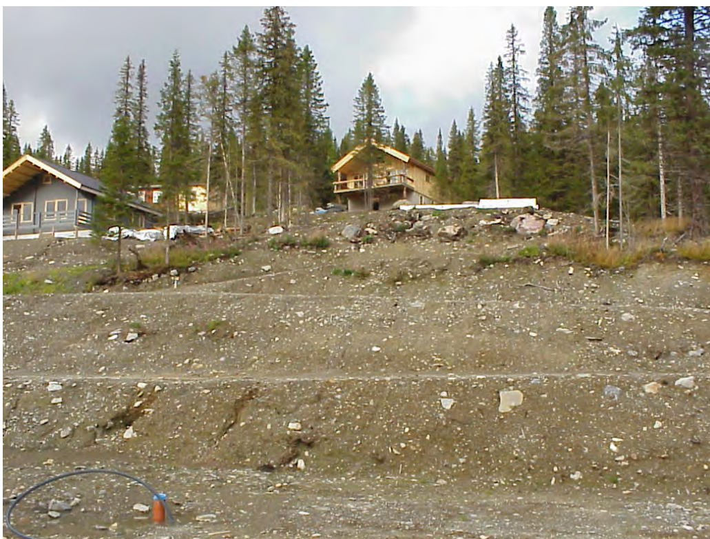
Figur 13. I samband med byggande av fritidshus i en finjordsrik sluttning har träd avverkats och all markvegetation skalats bort, vilket medfört att vatten börjat att erodera sluttningen. Risken för erosion och ras är nu stor. Genom att spara träd och buskar och inte blottlägga mer jord än nödvändigt hade dessa problem kunnat förebyggas. Foto: K. Lundström
