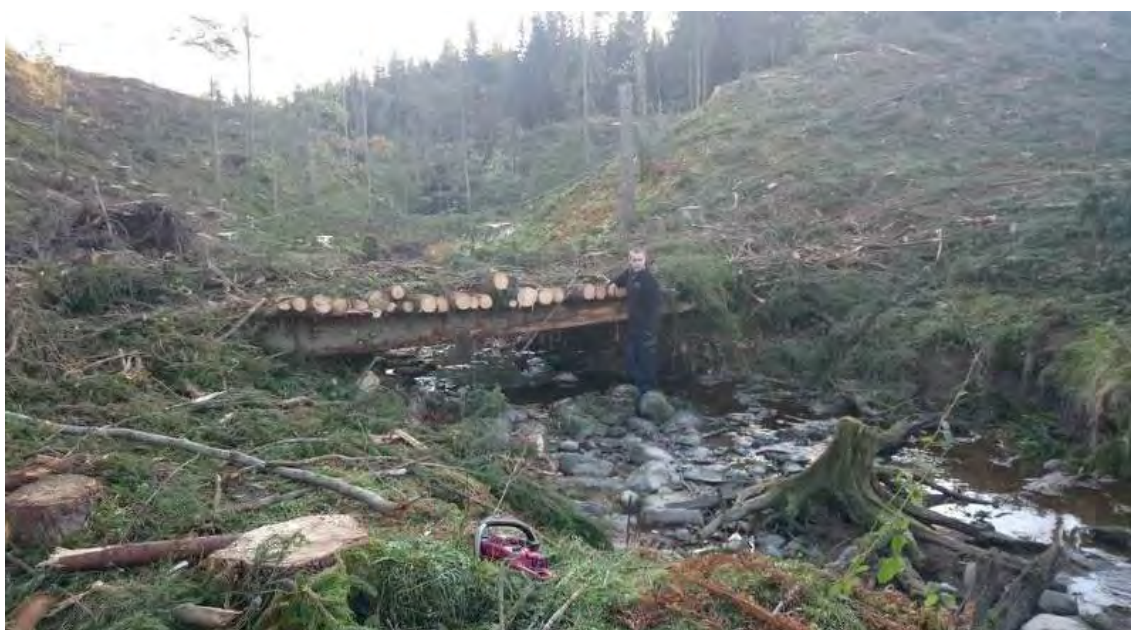
Figur 21. Genom att låta skördaren bygga virkesbroar av befintligt material på plats förebyggs mycket skador vid passage av vattendrag och diken. Detta är en teknik som utvecklats och används allt mer. Det är dock viktigt att påfarterna också stabiliseras samt att broarna underhålls eller avlägsnas så att dämning och efterföljande slamströmmar inte orsakas. Foto: A. Dahlström
