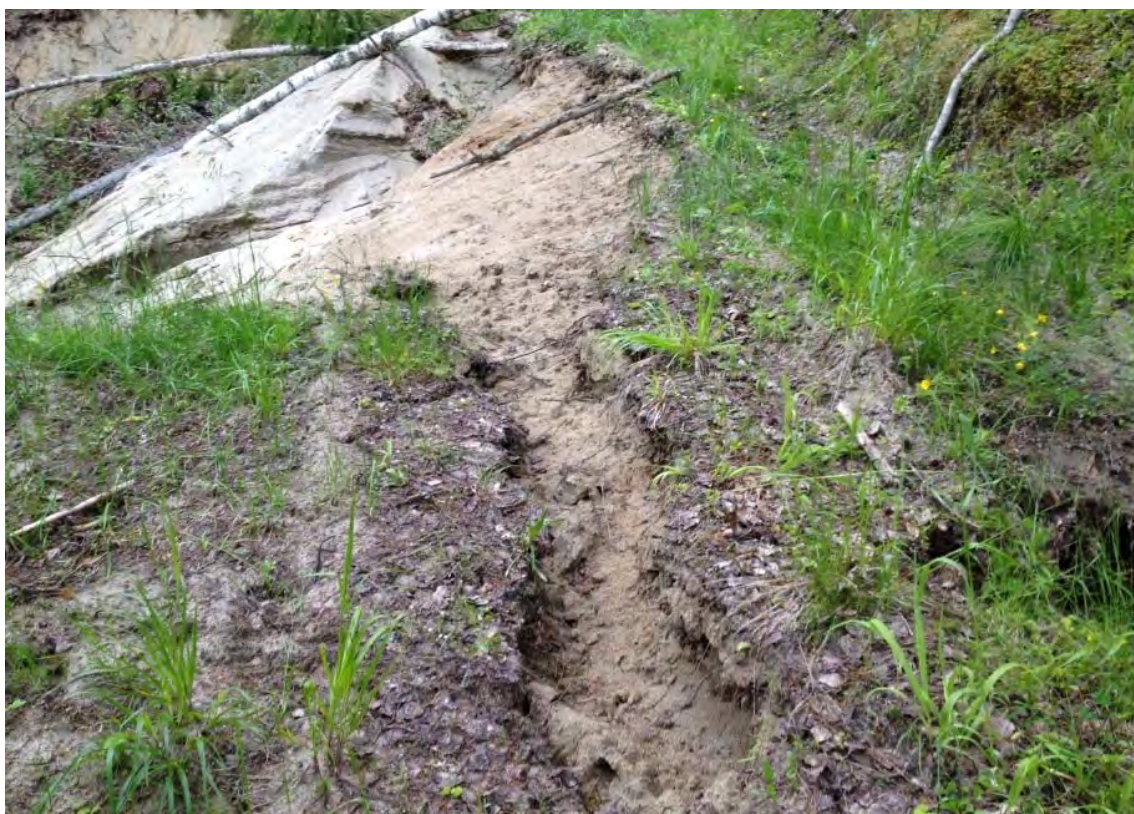
Figur 55. Nyligen uppkomna sprickor i marken kan vara ett tecken på att det finns risk för ras. Här har sprickorna uppkommit efter en avverkning i en sluttning. Foto: K. Lundström
