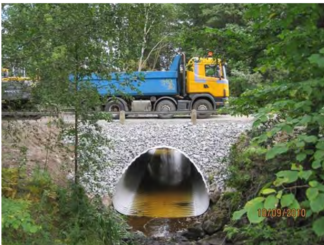
Figur 50. När botten och kanterna på vattendraget inte är stabila kan trummor med en bredare, plan botten vara en lösning. Dessa trummor bärs upp bättre och den bredare botten bidrar även till en sänkt vattenhastighet i trumman. Foto: F. Rangsmo
