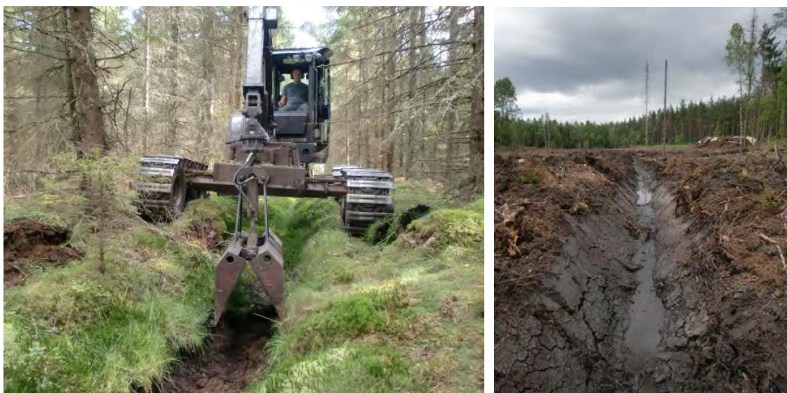
Figur 44. Små, lätta maskiner och gripskopor som endast lyfter bort nedrasat material från dikets botten är att föredra. Tekniken bidrar till att bevara den skyddande och stabiliserande vegetationen på dikeskanterna och river inte upp eller kompakterar marken i anslutning till diket (vänstra bilden). Används en större grävmaskin måste mer vegetation avlägsnas för maskinens framkomlighet och risken för markskador ökar. Används dessutom profilskopa riskerar man att blottlägga en större andel mineraljord längs dikeskanterna, vilket ökar risken för erosion (högra bilden). Foton: A. Lomander
