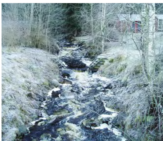
Figur 42. Genom att skapa trappor av stockar eller sten kan man också få vattnet att tappa energi och därmed rinna långsammare. Exemplet visar åtgärder i naturliga bäckar, men åtgärderna lämpar sig i såväl produktionsdiken på skogsmark som längs vägdiaken. Vid åtgärder i rensade rätade vattendrag eller naturliga vattendrag måste alltid kontakt med Länsstyrelsen tas då denna typ av åtgärd kan orsaka vandringshinder för fisk. Foton: K. Lundström och J. Hagström
