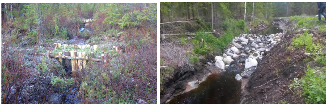
Figur 43. Anläggande av stenkistor eller risproppar är ytterligare alternativ för att bromsa upp vattenhastigheten. Foton: H. Krekula & M. Gjåls
