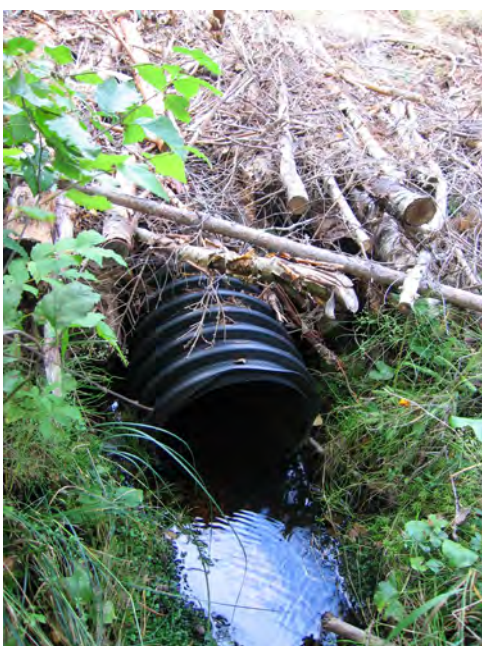
Figur 23. En trumma som lagts ut tillfälligt för att bas- eller stickvägen inte ska orsaka dämning eller skapa ett koncentrerat flöde av vatten. Foto: A. Lomander
