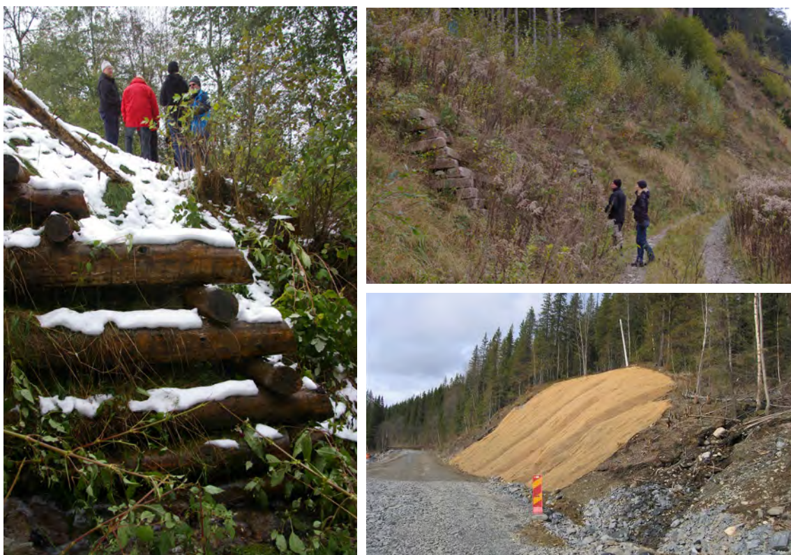
Figur 27. Exempel på erosionsskydd av branta slänter med hjälp av stockar, stenblock eller nät av till exempel kokos. Foton: A. Lomander, K. Lundström
