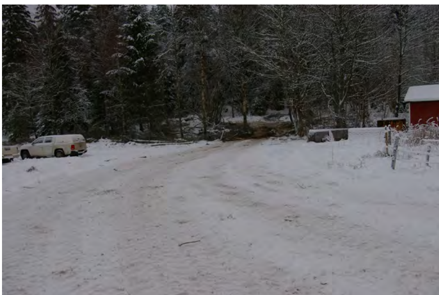
Figur 18. Stampad vinterväg, det vill säga man har förberett basvägen genom att skotta och köra på den upprepade gången innan avverkningen startar. Syftet är att få tjälen att tränga djupare ned och bli bärande genom att ta bort det isolerade snötäcket, trycka samman markvegetation samt markens porsystem. Här har man lyckats köra ut 1 000 m 3 sk från avverkning i en slänt, över en blöt ängsmark och fram till avlägg vid väg, utan några körskador. Foto: A. Lomander
