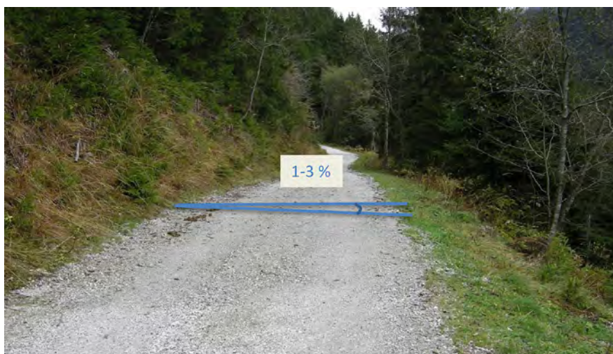
Figur 29. För att leda vatten från vägplanet och ut i terrängen kan vägplanet lutas mellan 1 och 3 procent. Foto: K. Lundström.
