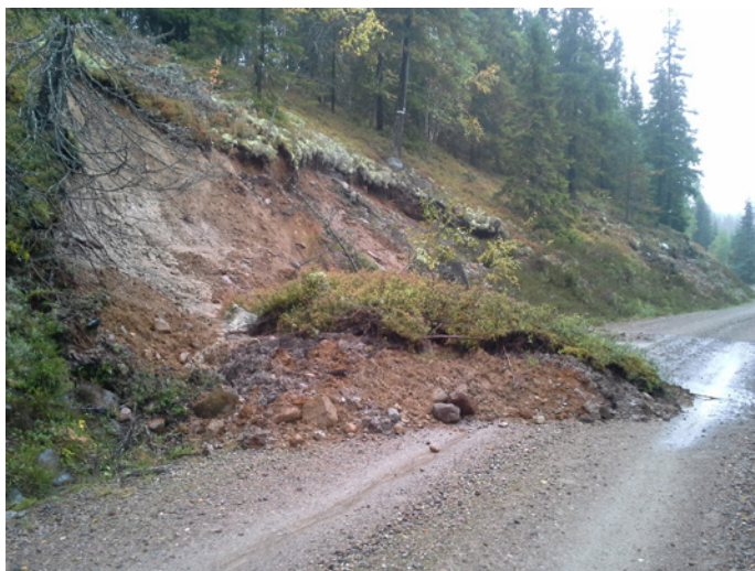
Figur 11. Ras i slänt söder om Sälénfjällen i samband med regnoväder september 2015.
