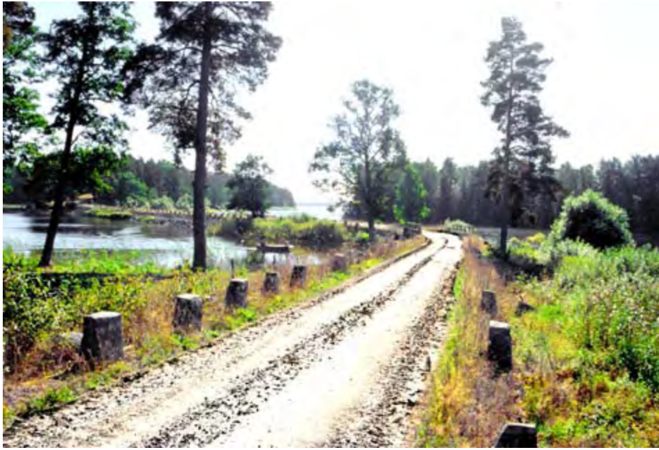
Den urgamla körvägen från fastlandet via en vägbank över till ön Åkerö i sjön Yngaren. Vägbanken byggdes på 1750-talet. Ön var redan under medeltiden säte för en betydande herrgård. Foto: Eliz Lundin, september 1999.
