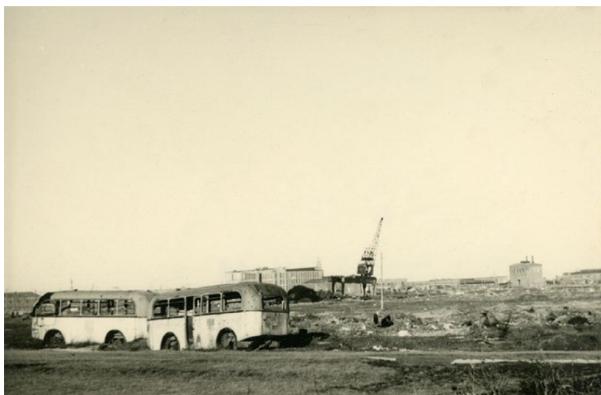
Fotografi från 1945 eller 1946 av förstörelsen i Gdynia som följde av andra världskriget, stora delar av staden var förstörda. I denna bild kan man skymta hamnområdet i bakgrunden, vid lyftkranen och byggnaden till vänster om den.
